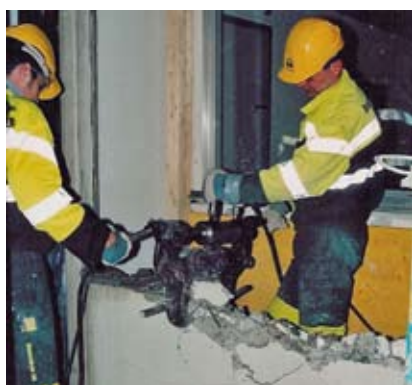
Knacken mit Handzange in bewohntem Gebäude
