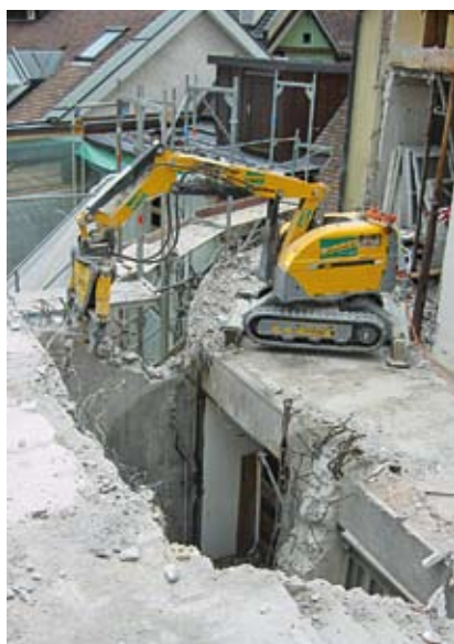
St. Gallen, Multergasse 1-3: Zangenabbruch mit Brokk 150
