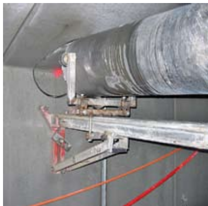
Neubau Uetlibergtunnel, Werkleitungskanal
