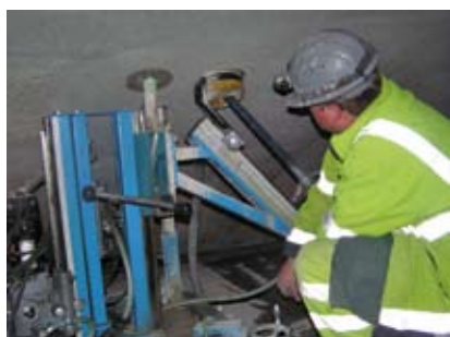
Aeschertunnel, Verstärkung Zwischendecke
