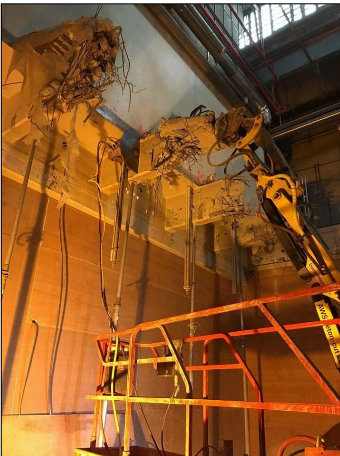
Sciage au disque anti-bruit de 4 poutres Ht. 1.00 m
