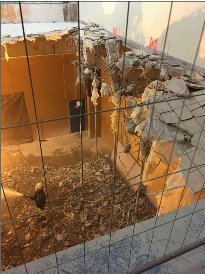
Arrosage durant la démolition
