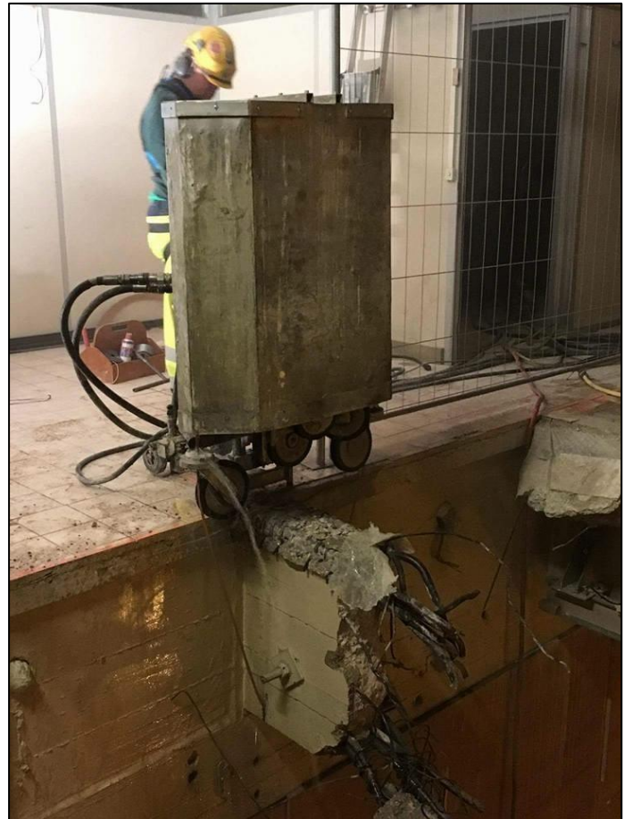
Sciage au câble de 4 poutres Ht. 1.00 m
