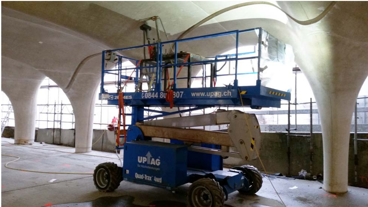
Hebebühne mit Bohreinrichtung
