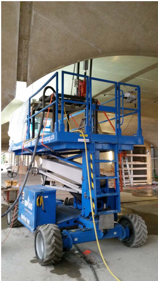
Hebebühne mit Bohreinrichtung
