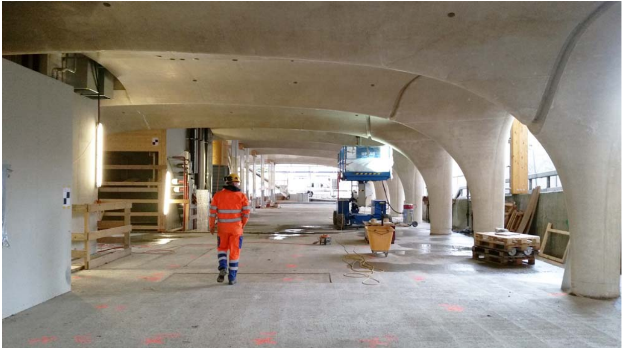
Ansicht der Baustelle
