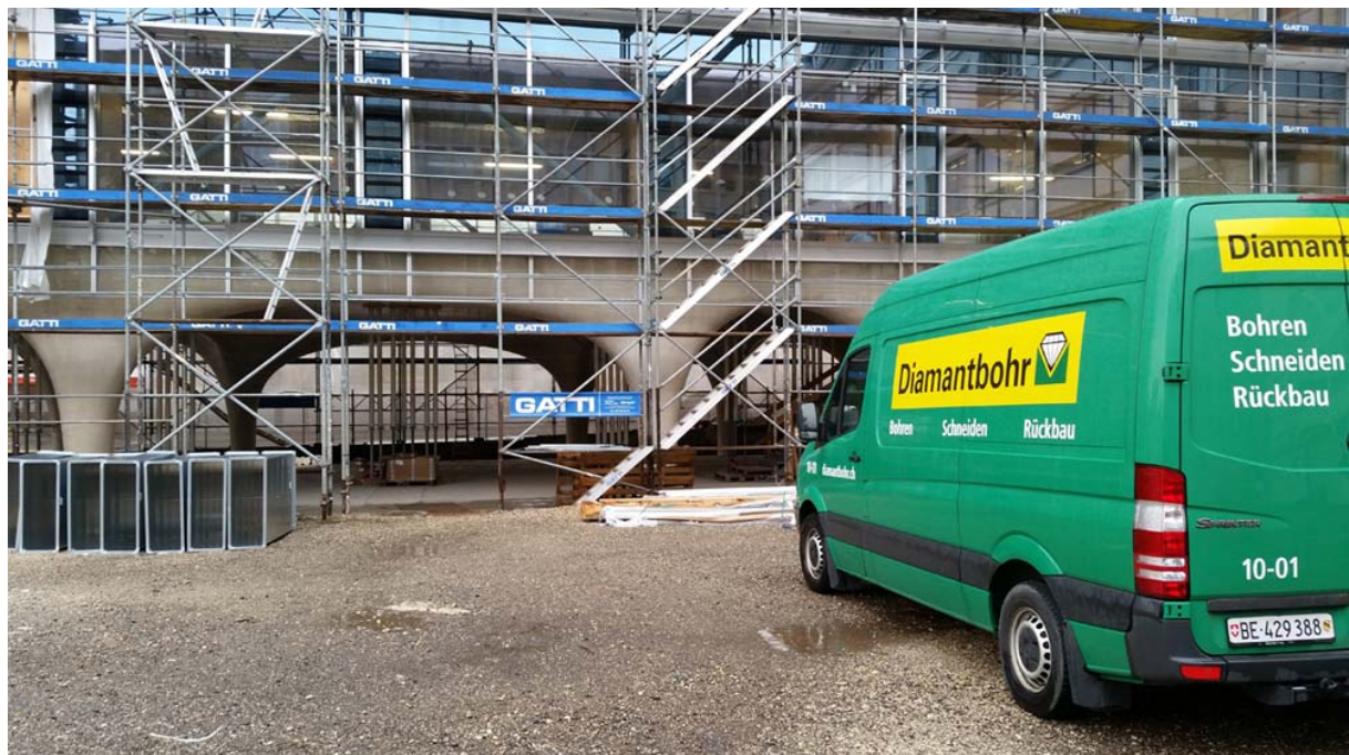
Ansicht der Baustelle mit exklusivem Parkplatz
