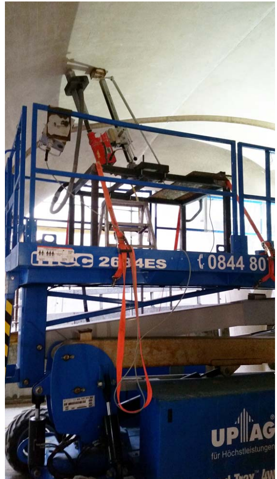
Hebebühne mit Bohreinrichtung im Detail
