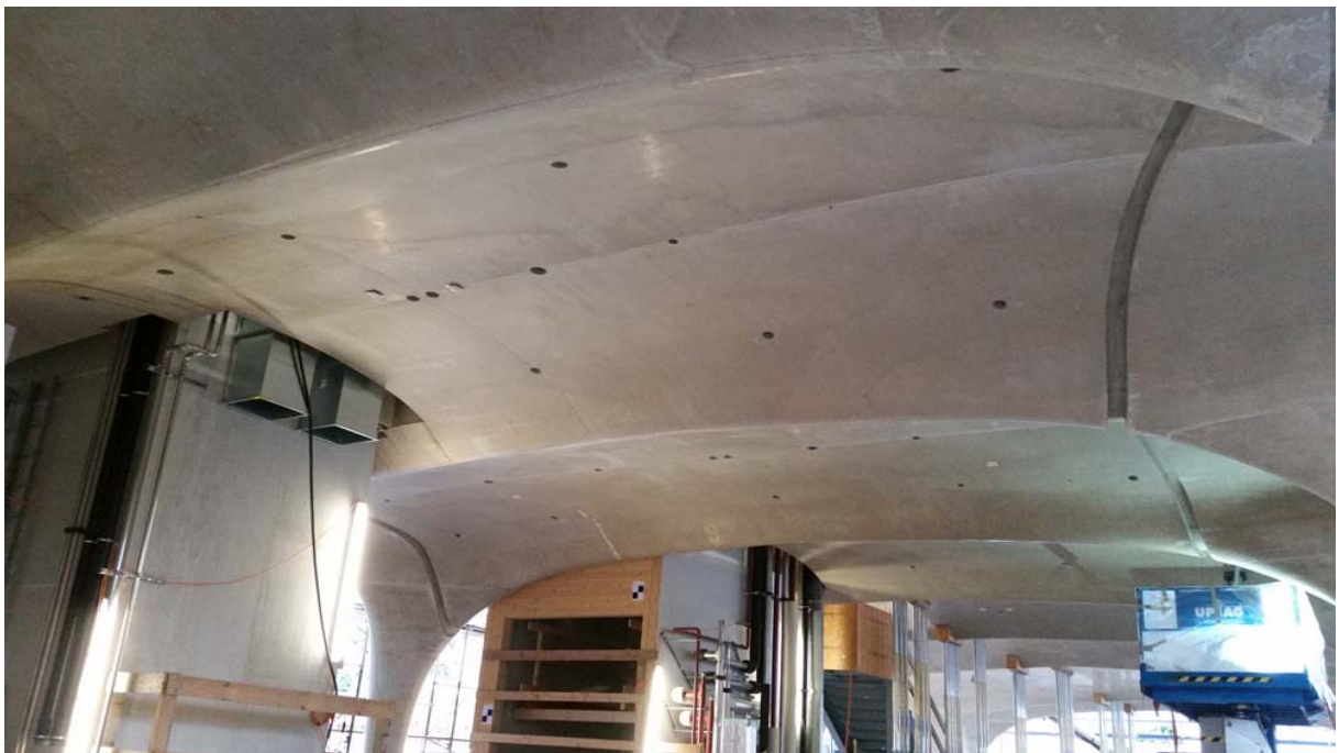
Ansicht Gewölbe mit Bohrungen
