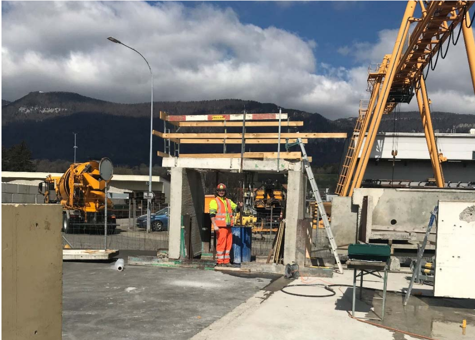
Abmontage des Kernbohrsystems nach getätigter Überkopfböhrung mit \varnothing 300mm. Simulation Wohnung mit Voraussetzung des sauberen Arbeitens.
