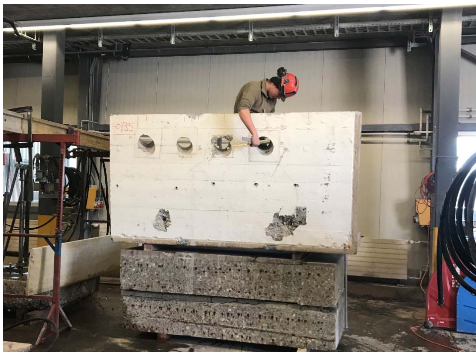
Doppelgeneigte Kernbohrung 40^{\circ}/35^{\circ} , selbständige Ausführung inkl. Rapportierung und Abgabe.
